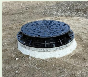
新設マンホール
