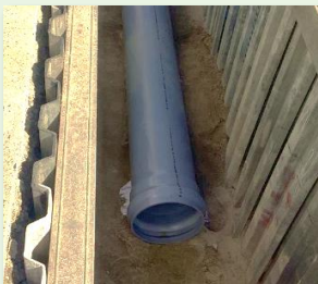
新設下水道管
